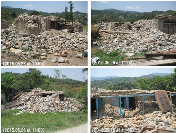
写真17 リク川周辺の破壊された民家
