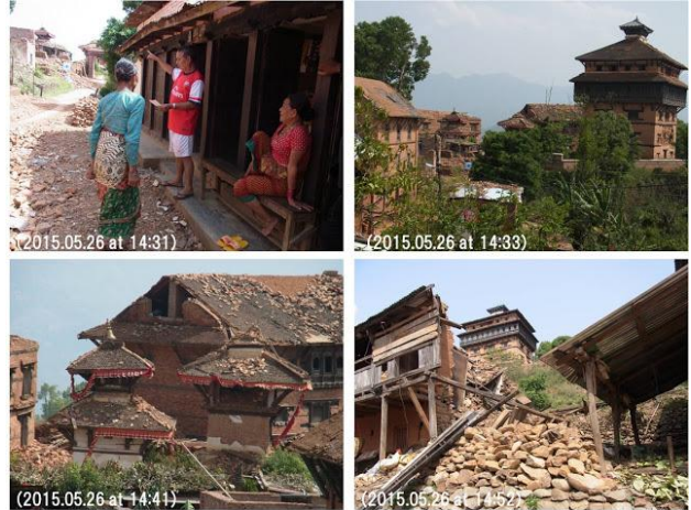
写真18 スワコット王宮の破壊状況
