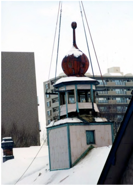
(f) 玉ねぎ塔解体
