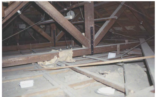
(d) 小屋裏 (照明のバランスウェイトの玉石が見える)
