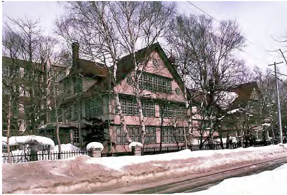
(a) 解体前の本館(1982年)
