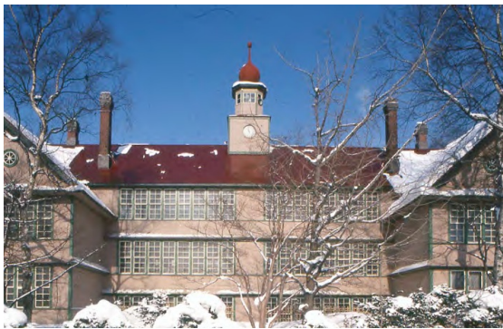
(b) 解体前の本館南面(1982年)
