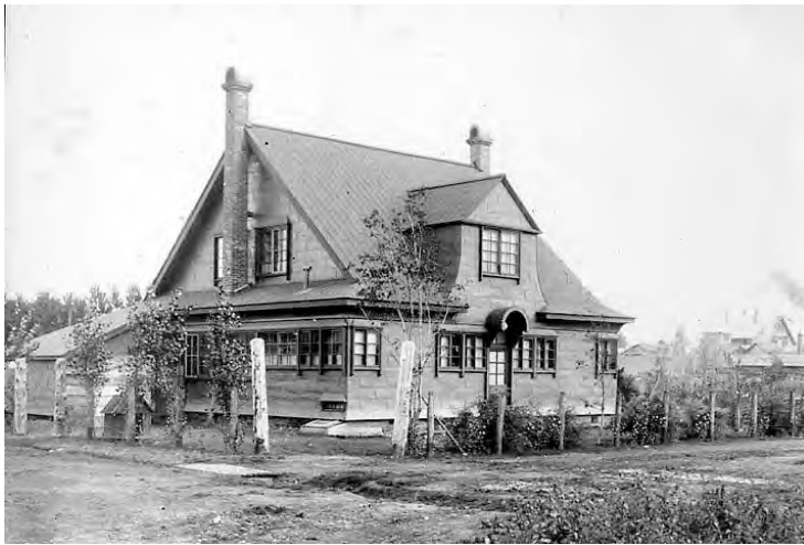
(a) 外観、外壁が鉄板葺
