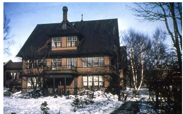
(e) 解体前の本館西面(1982年)
