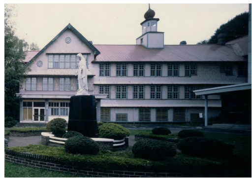
(d) 解体前の本館北面(1999年)
