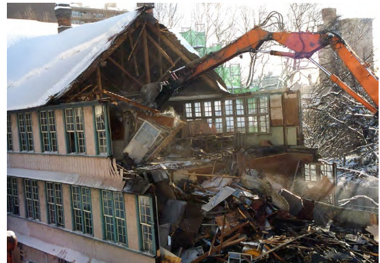
(g) 解体工事開始
