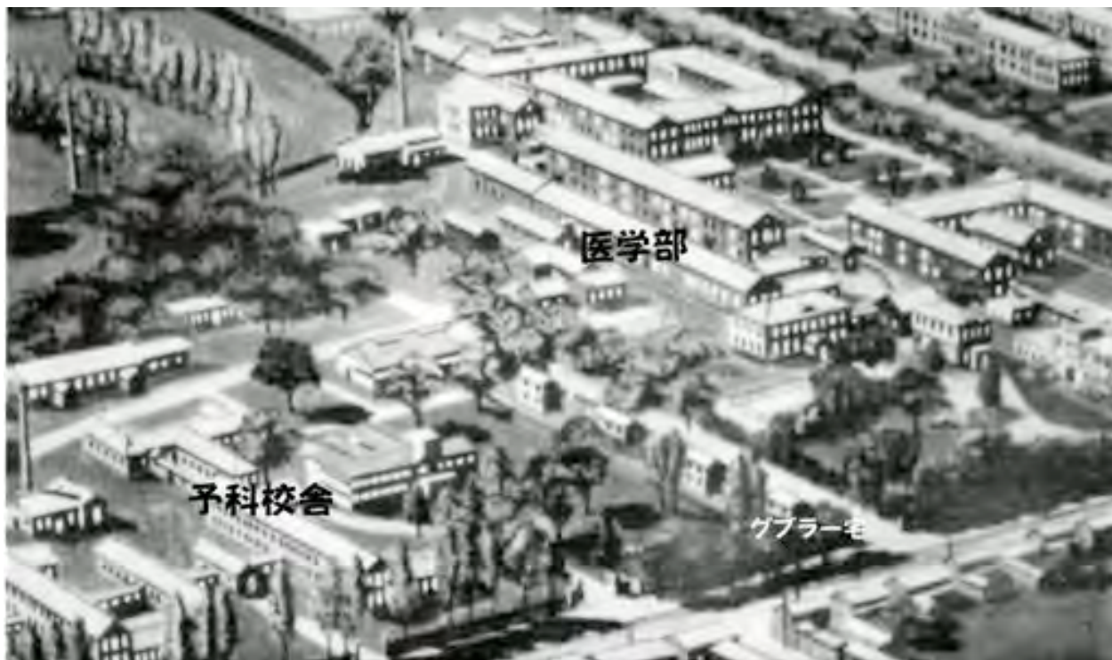
(25) 昭和 7 年)の北大予科及び医学部校舎付近の鳥瞰図。外国人講師住宅が 4 軒並んでおり、一番右がグブラー宅だった。
