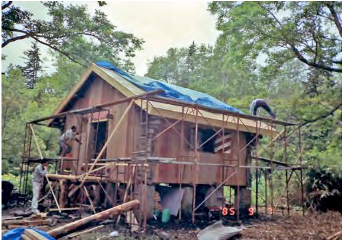
(30) 1985 年、改修工事中のヒュッテ
