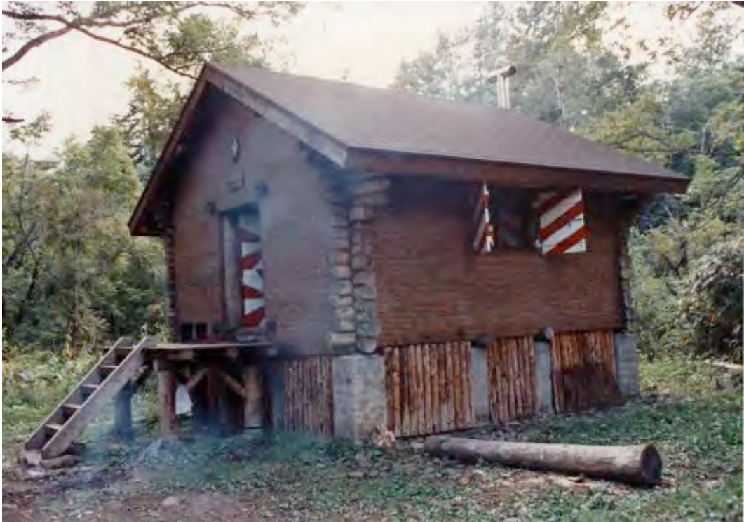
(31) 1985年、OBらの寄金で改修なったヒュッテ。屋根はアスファルトシングル、水切り銅板葺き、外壁はグラスウールに耐熱ベニア張り、その上に手割り柵張りとし、断熱効果を高めた。改修に当たっては、ヒュッテ当初のイメージを忠実に伝えることに努めた。
