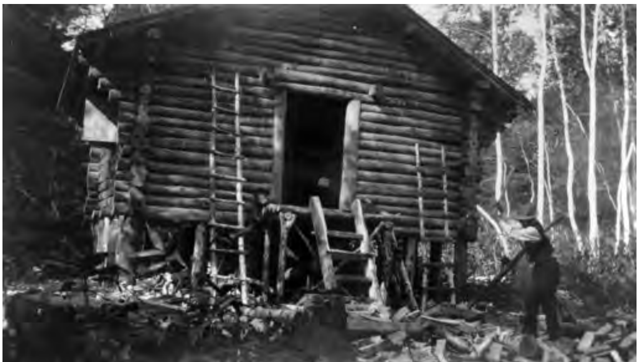
(6) 完成直後のヒュッテ 薪を割るのは部員の井田清
