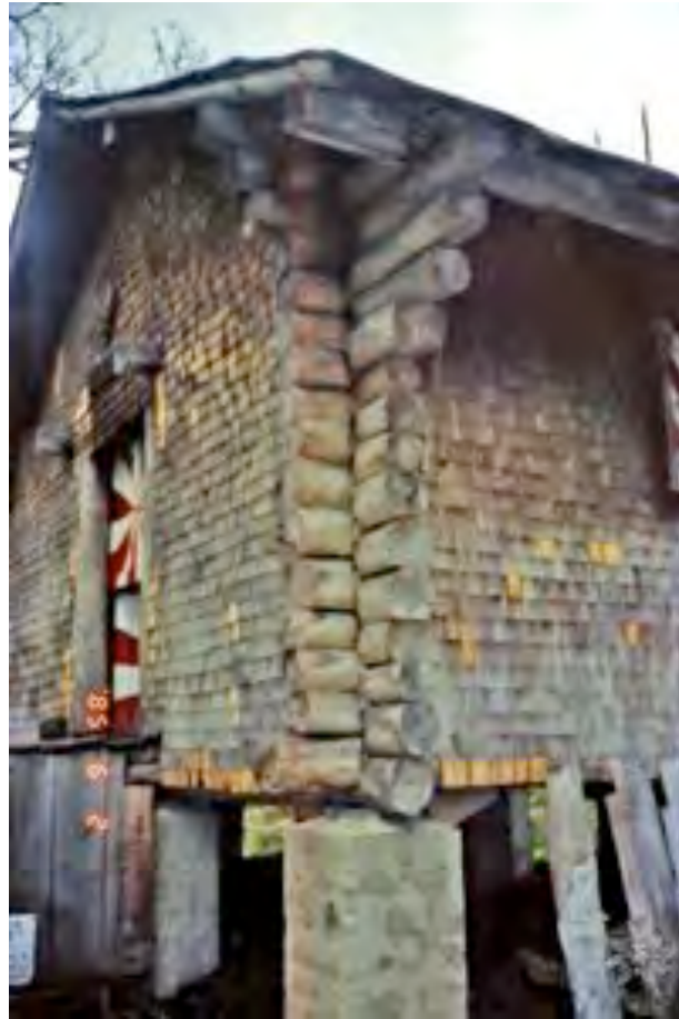
(29) 改修工事前のヒュッテ。建設から 60 年、ヒュッテは改修の時期を迎えた。
